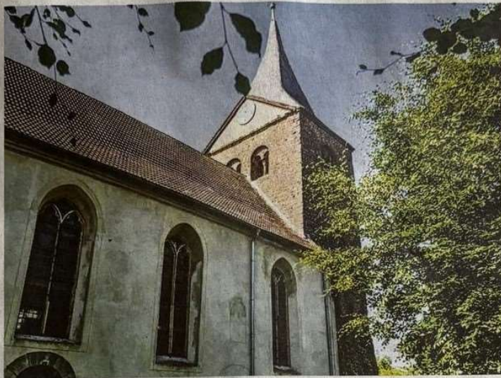
Die St. Peter und Paul in Niederdodeleben ist ein Sanierungsfall.
