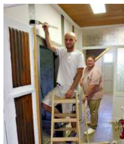
Im Dorfgemeinschaftshaus streicht Kevin Tschorn (l.) die Wände und André Wiklinski fegt durch. FOTO: SASKIA LOHÖFER
