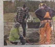
Die neue Anlage nimmt sichtbar Form an – doch es ist noch viel zu tun.
