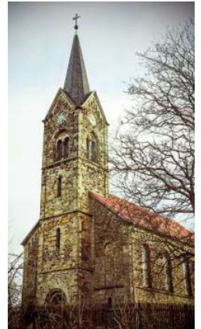
Ein weiterer Sanierungsabschnitt der Druxberger Kirche kann mit Hilfe der Förderung beginnen. FOTO: RONNY SCHOOF
