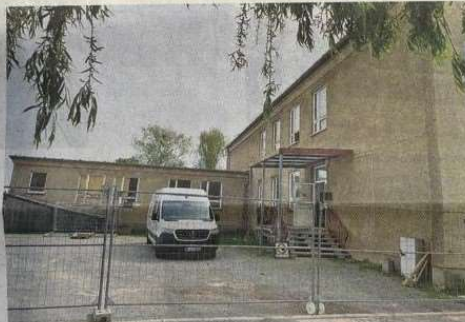
Im Frühjahr hatten die Abrissarbeiten mit der Entkernung des Gebäudes begonnen. Nun ist vom einstigen Schulgebäude nichts mehr übrig geblieben.
