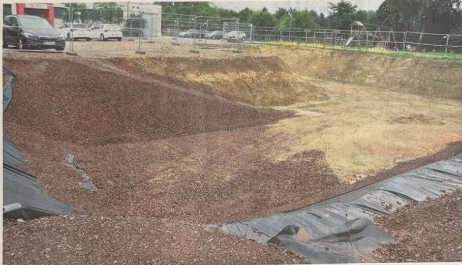
Im Zuge der Altlastensanierung wurde die alte Schule im Olve-Zentrum von Schackensleben abgerissen und das Gelände für einen Feuerwehrneubau beräumt. Ende kommenden Jahres, so ist es geplant, sollen die Kameraden mit ihrer Technik Einzug halten können. Bis dahin ist mit Einschränkungen zu rechnen. FOTOS: CARINA BOSSE
