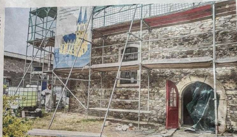
Die Döhrener St.-Marien-Kirche ist eine riesengroße Baustelle. Sowohl außen als auch im Inneren sind Handwerker bei der Arbeit. Zunächst werden die baulichen Schäden behoben. Der Fußboden muss auf ein Niveau gebracht werden. FOTOS: MARITA BULLMANN
