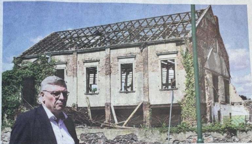
Bürgermeister Andreas Burger berichtete vom Teileinsturz der alten Gaststätte im vergangenen Jahr. FOTOS: CARINA BOSSE
